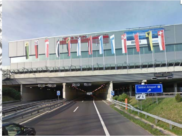
Exemple : GE N01 Palexpo – alignements parallèles à l'axe de la route en partie manquants, pas de délimitations verticales.
