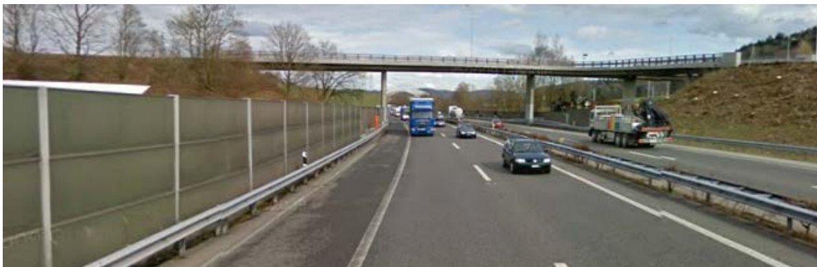
Exemple : AG N01 Safenwil - alignements interrompus au niveau d'ouvrages de passages supérieurs de routes traversantes, alignements non fermés.
